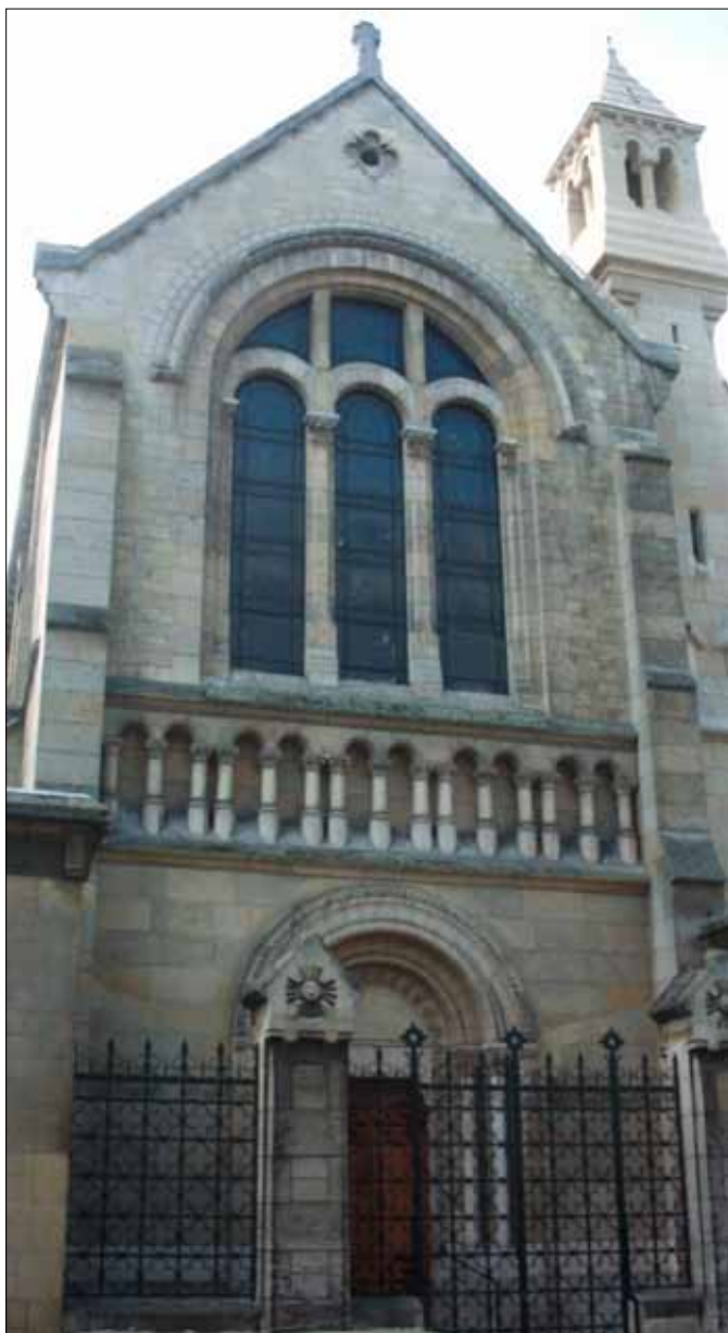
Fachada actual de la iglesia
